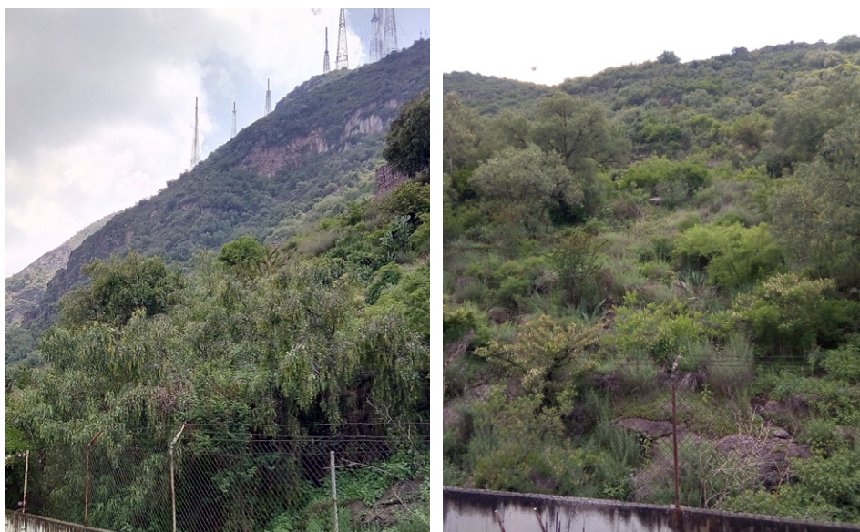
Figura 5 y 6. Muro ecológico o límite del Área Natural Protegida, en el Chiquihuite Fuente: Autores, 2023.
