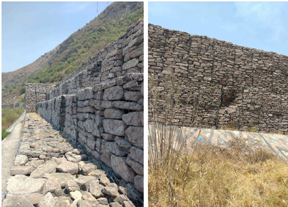
Figura 7 y 8. Muro de Gavión. Estructura de protección para la contención de rocas Fuente: Autores, 2023.
