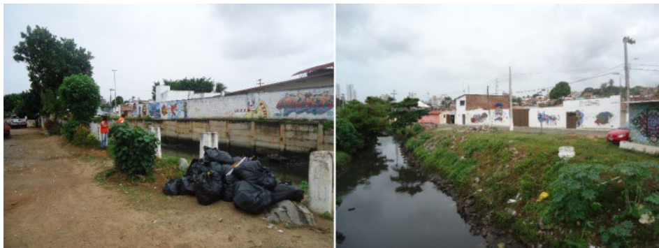
Figura 9. Imagens do Canal do Baldo no Complexo do Passo da Pátria, em sua vista lateral, apresentando muito lixo, sujeira, estruturas precárias e águas residuais
