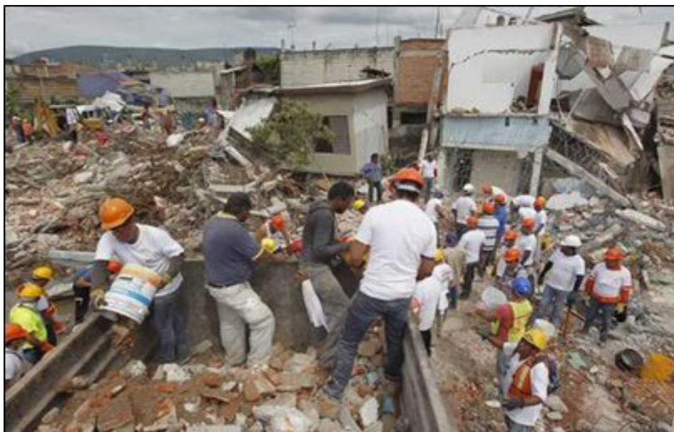
Figura 3. Voluntariado en la colonia Emiliano Zapata, Jojutla
